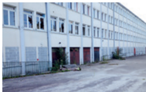
La barre avant les travaux
