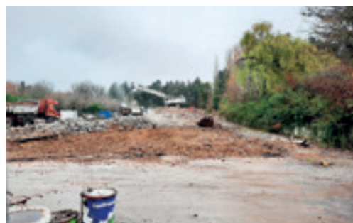
Les travaux de destruction
